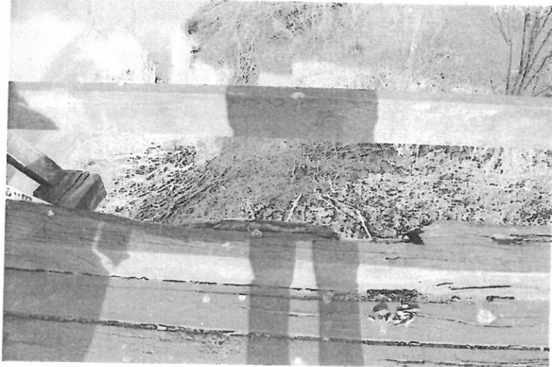
7. Podină de uzură deteriorată
