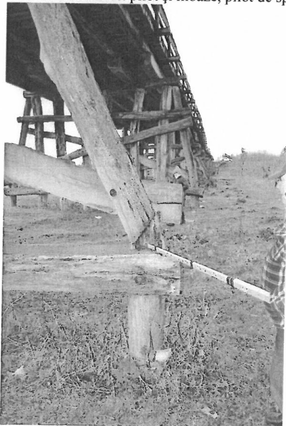
15. Necesară înădărit pilot și moaze, pilot de sprijin
