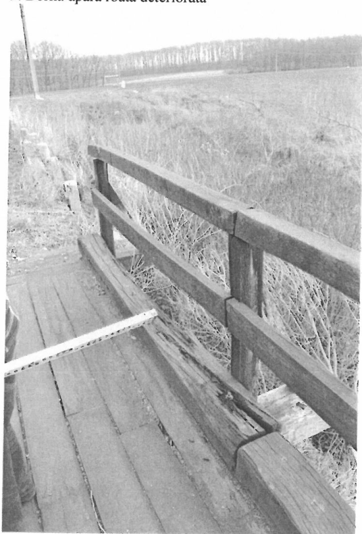
9. Bornă apără roată deteriorată
