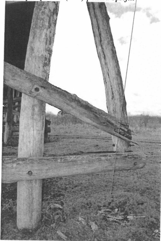
15. Necesară înădărit pilot și moaze, pilot de sprijin
