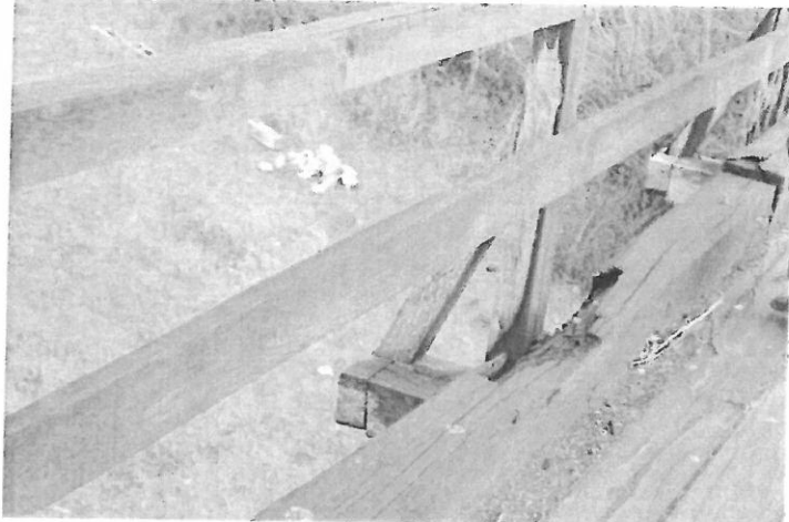
9. Bornă apără roată deteriorată
